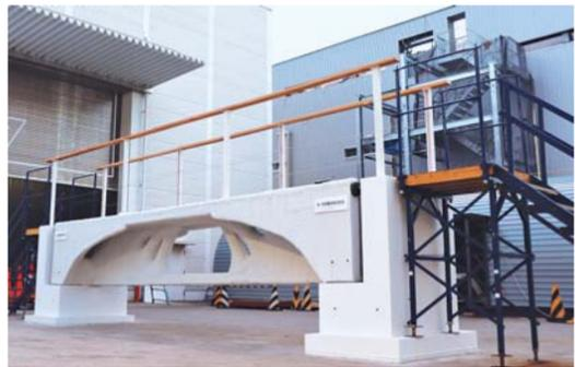
大成建設(東京都新宿区、村田誓之社長)は、建設用3Dプリンターで作った部材にプレストレストコンクリート(PRC)鋼材を挿入して橋を製作した。
