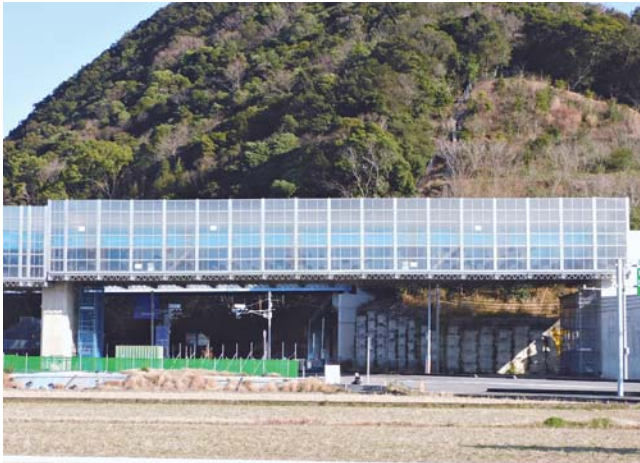
クイックパネライトは完成した橋の遮音壁のよう
