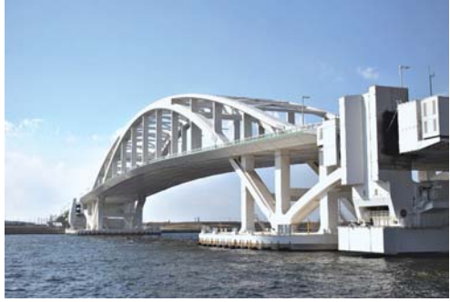
大阪市此花区の市道に架かる鋼旋回式浮体橋。平成13年。橋長876.6m (65.7+280.0+65.7m)、総幅員38.8m。
