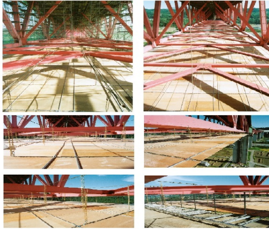
VMAX施工現場内部
