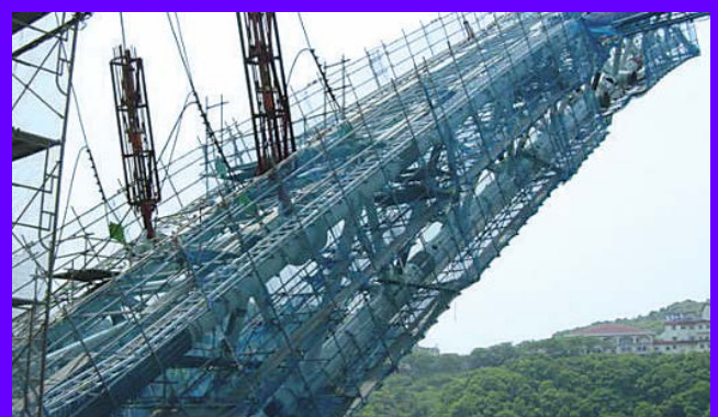
メタルアーチ橋での昇降設備(工事進捗により角度が変わる)
