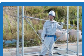
先行手すり筋交いの設置
