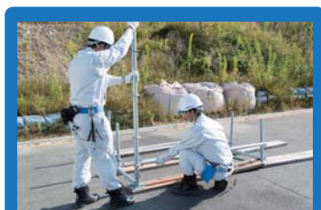
根がらみの設置
