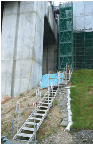
上部工工事の昇降用通路
