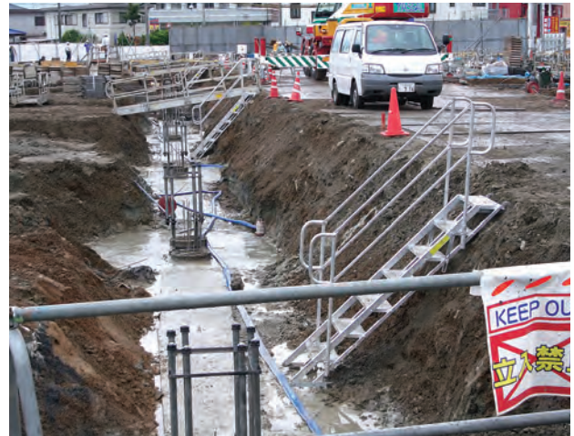
基礎工事の時の昇降設備
