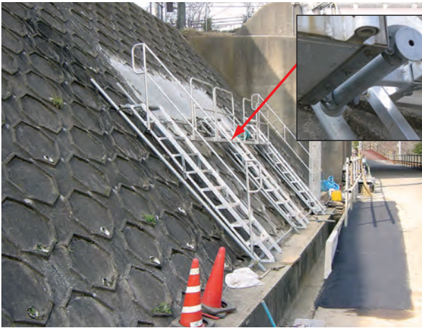
鉄道擁壁工事に仕様(作業足場の設置例)
