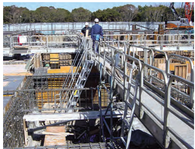
地中梁鉄筋を乗り越える為の使用
