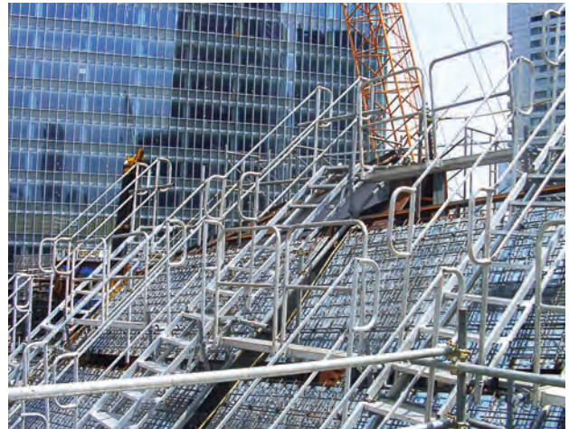
急傾斜屋根の足場及び昇降設備(作業ステージユニット)
