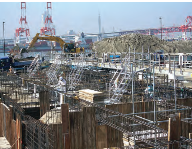
安全通路よりピットへの昇降設備
