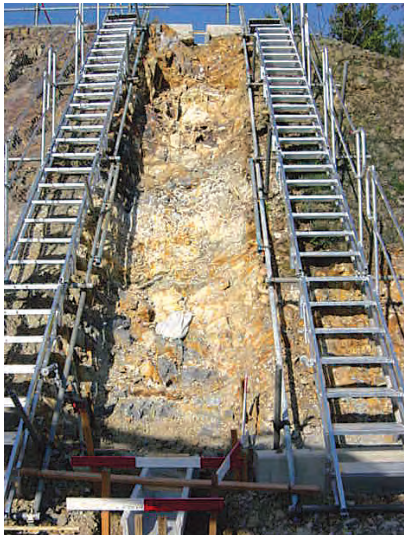
砂防流路工事(昇降及び作業足場)
