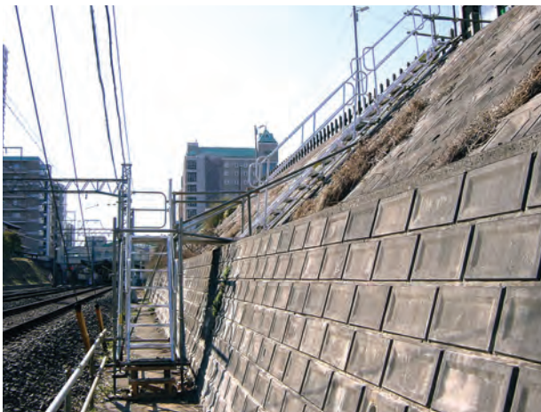
鉄道関係の保守工事用として使用
