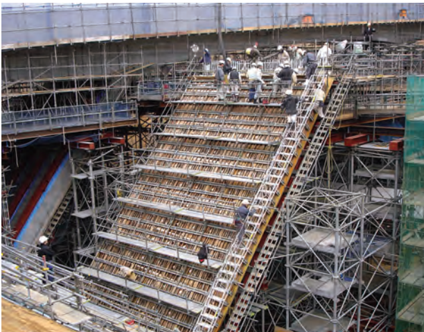
跨道橋架設の昇降設備
