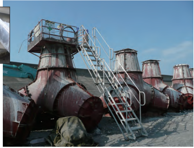
テトラポット製作用 昇降設備
