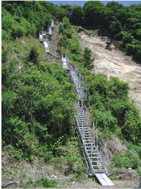
法面工事準備段階で使用
