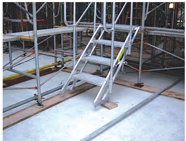
枠組足場(調整枠)用の昇降設備
