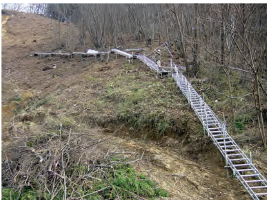
作業員の昇降用通路(組立状況)
