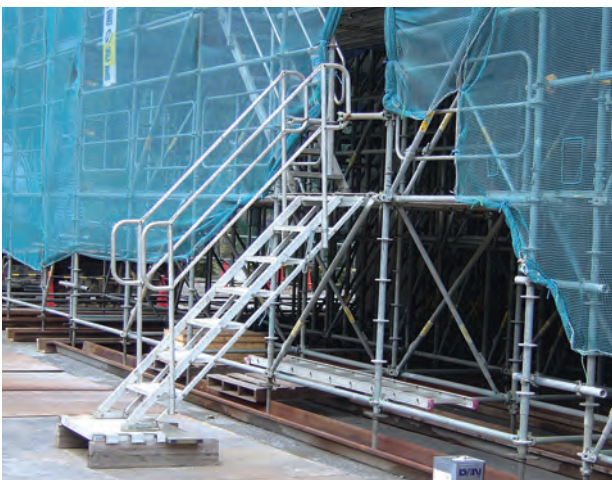
足場支保工への昇降用通路
