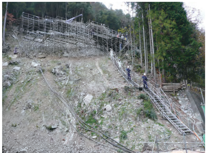
作業員の昇降用通路
