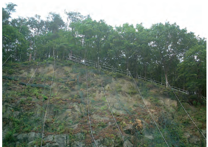
親綱点検用としての昇降設備
