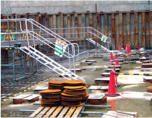
地足場より作業場への昇降設備
