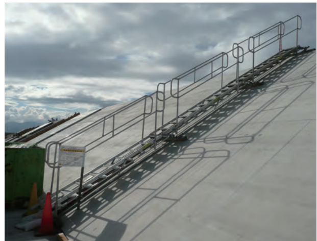
沿岸部護岸工事の昇降設備
