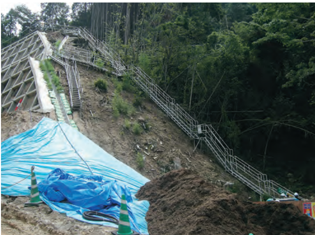
-砂防流路工事(昇降及び作業足場)
