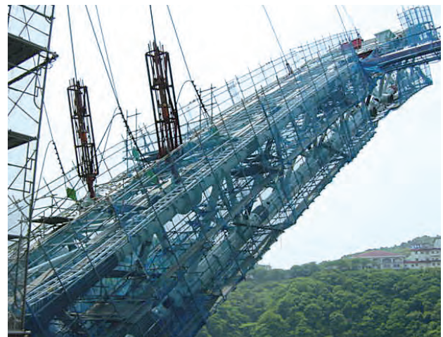
メタルアーチ橋での昇降設備(工事進捗により角度が変わる)
