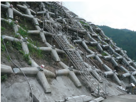
作業員の昇降用通路
