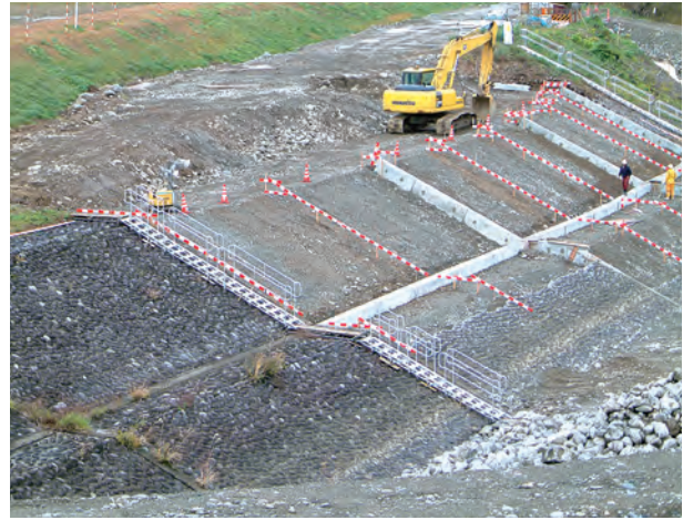
河川護岸工事用の昇降設備
