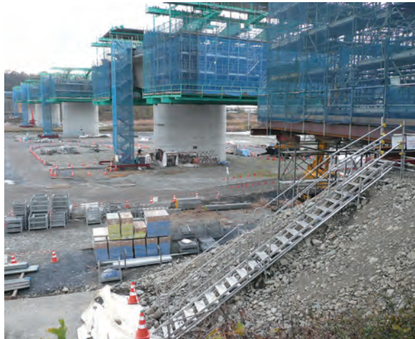
上部工工事の昇降用通路
