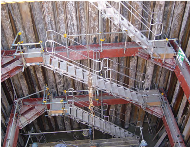
立坑工事での昇降設備
