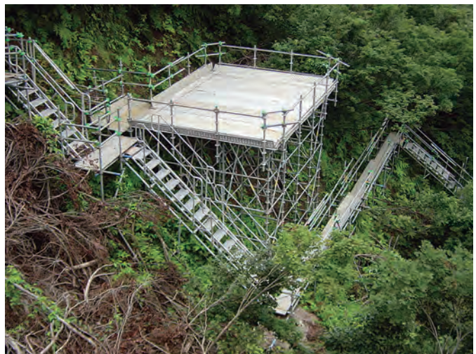
作業員の昇降用通路(踊場設置例)
