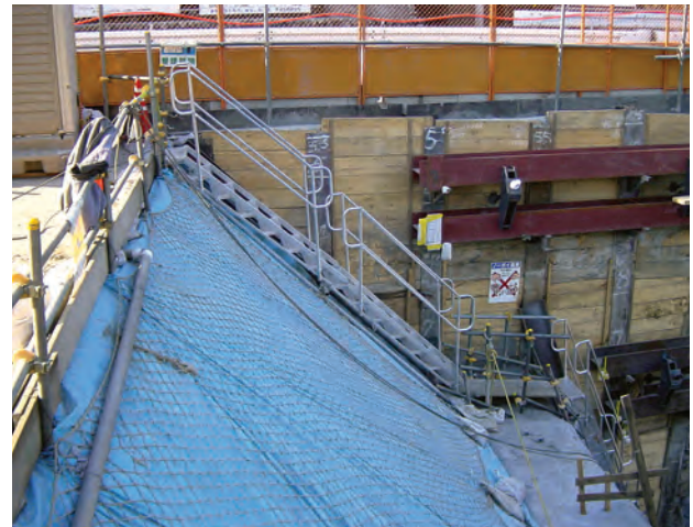
橋梁基礎部への昇降設備
