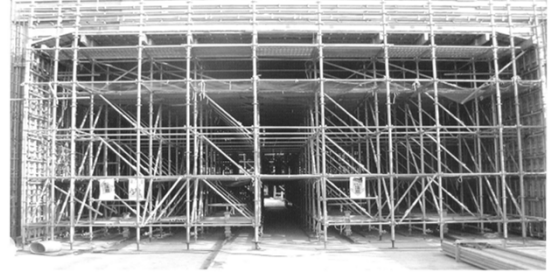
3S-SYSTEMによる型枠支保工(全体移動)リフティング走行台車
