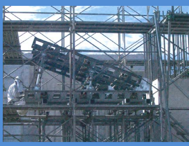
施工時(左ウイング)
