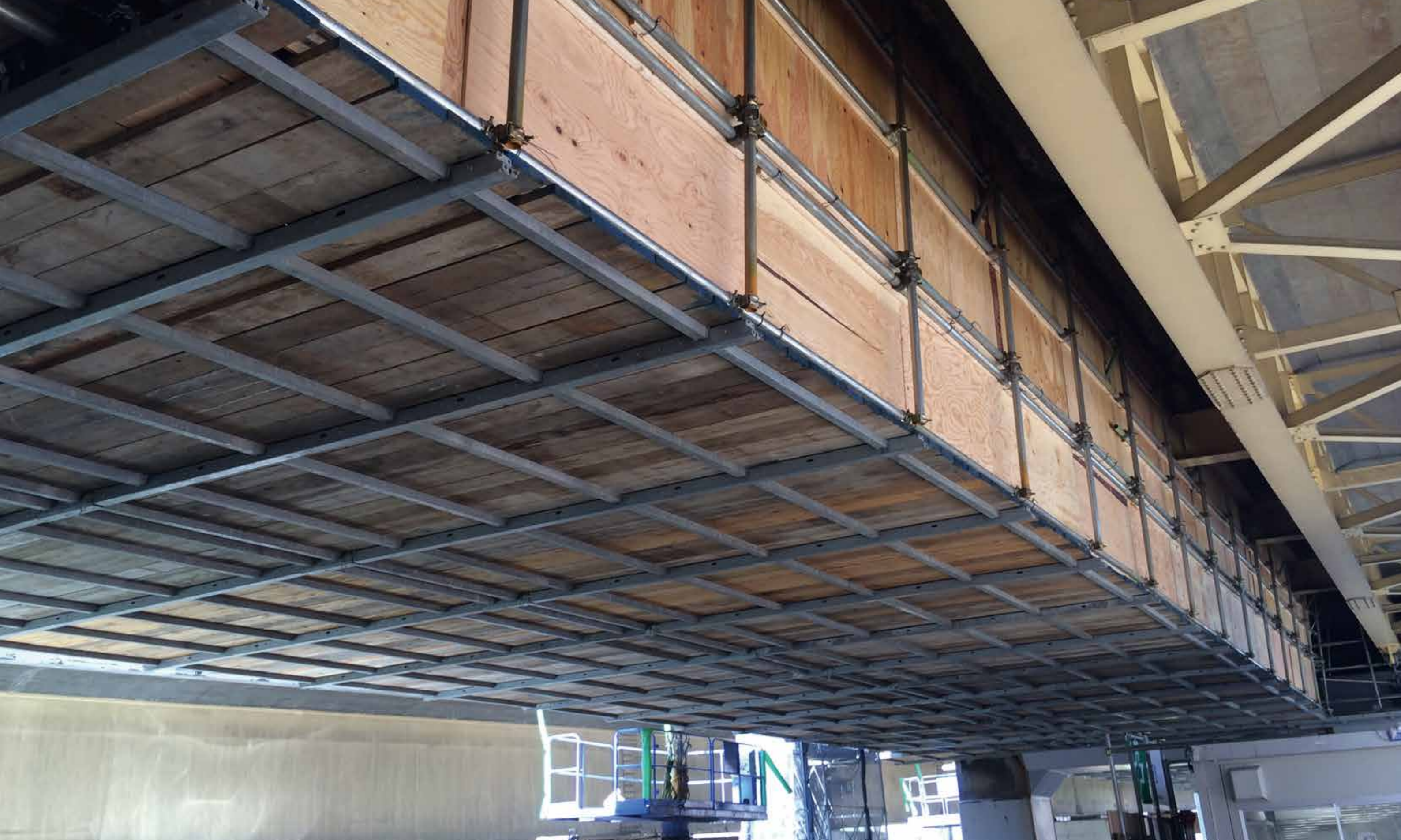
あらゆる現場に対応する、進化した吊り棚足場。
