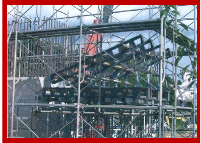
施工時(右ウイング)
