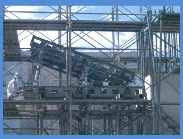
施工時(左ウイング)
